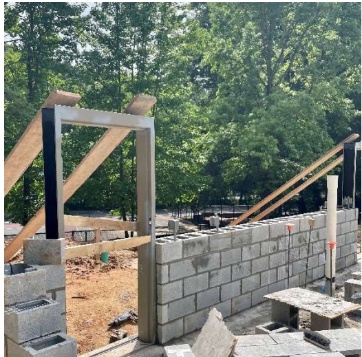
12" Exterior CMU Install
