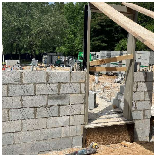
12" Exterior CMU Install
