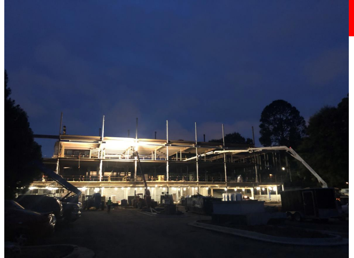
Third Floor Slab Pour
